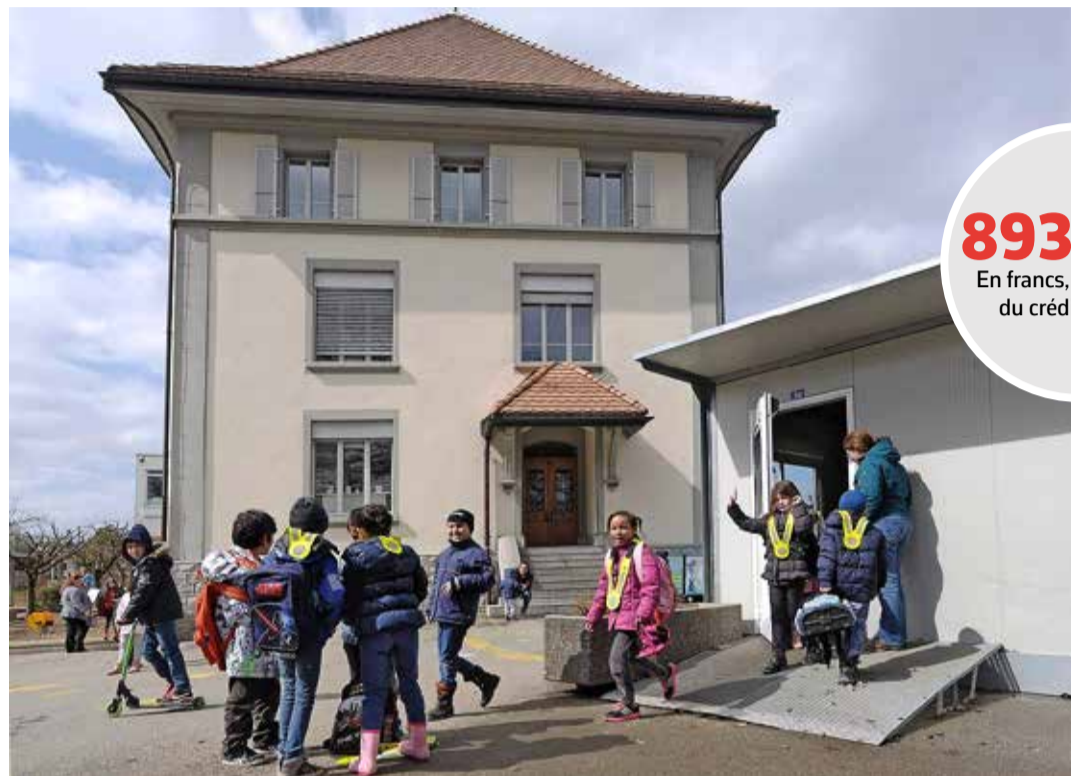
Le bâtiment de la petite enfance doit prendre place sur le site de l'actuelle école de Belfaux.
